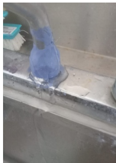
REVISION PARA REHABILITACION COCINAS
